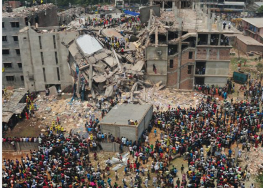
Ingestorte kledingfabriek Bangladesh
