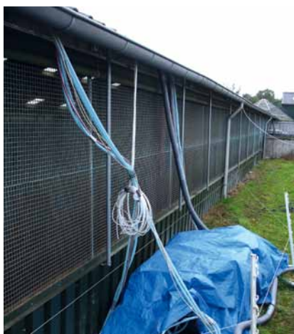
Vast opgestelde pompen onder zeil met de slangen het gebouw binnen, deze bleven het hele jaar liggen.
